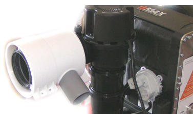
Abb. 5 , Zuluft-T-Stück über die Muffe schieben
