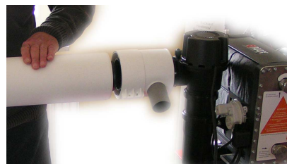
Abb. 6 , Montage PolyTwin-Verbindungsstück
